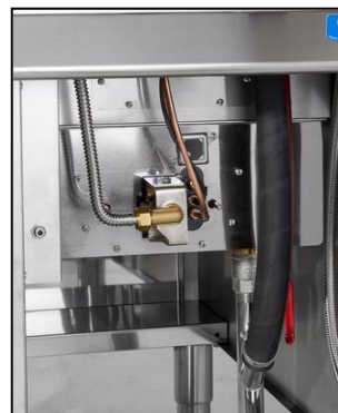
Part. vano tecnico interno
