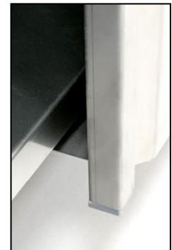
Part. guida e ancoraggio anta scorrevole
