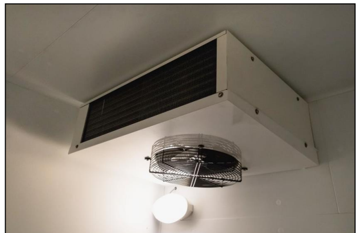
Part. illuminazione interna e gruppo condensatore/ventola
